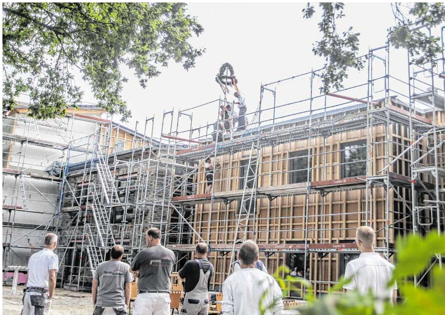
Oben am Neubau der Diakonischen Behindertenhilfe wehte am Freitag der Richtkranz.
