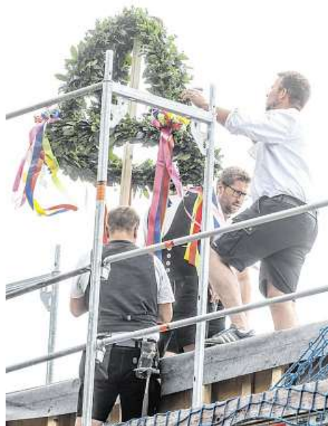
Die Zimmerleute beim Ausrichten des Richtkranzes oben auf dem Dach des Neubaus.
